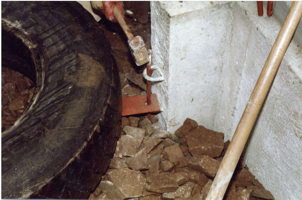
**Accrochage des pneus poids lourds sur le parement béton**
