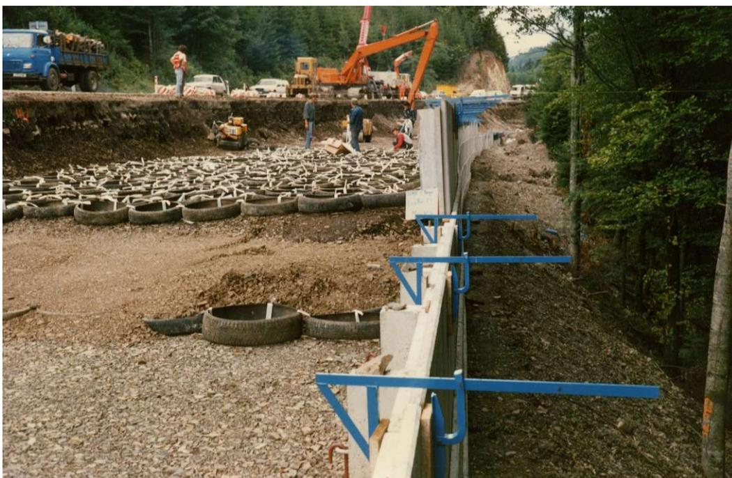
**Mur avec parement en béton et des renforcements en Pneusol –Disposition des nappes**
