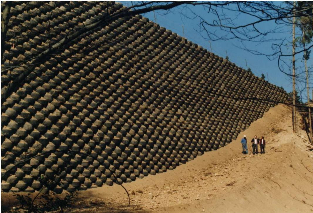
**Mur avec un parement en Pneusol et des renforcements en treillis soudés (Armapneusol)**
