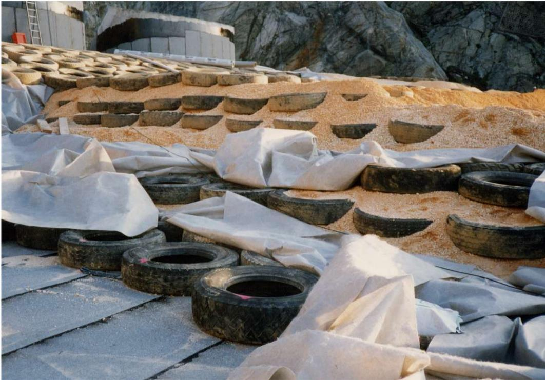
Pneusol absorbeur de contraintes (chutes de blocs) sur le toit de la station d'épuration au Cap Sicié
