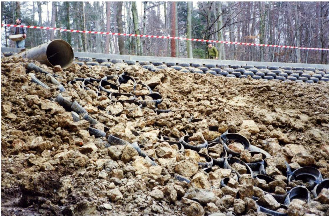
**Mur en Pneusol avec brise de jet d'eau**
