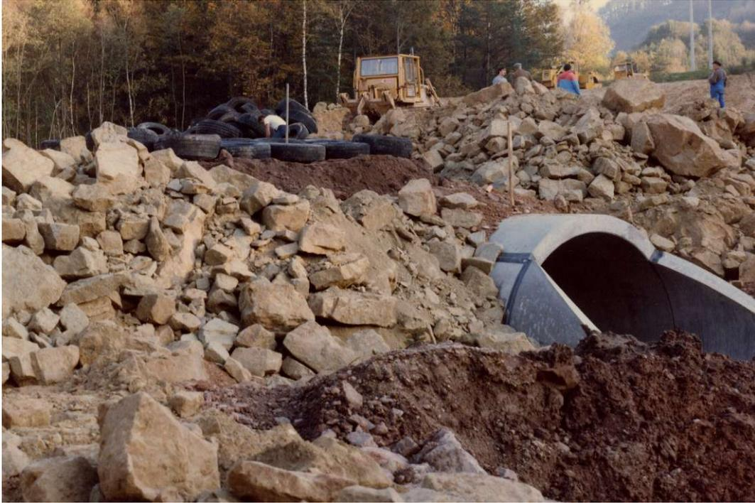
**Répartiteur de contraintes au-dessus des conduits enterrés sous fortes hauteurs de remblai**
