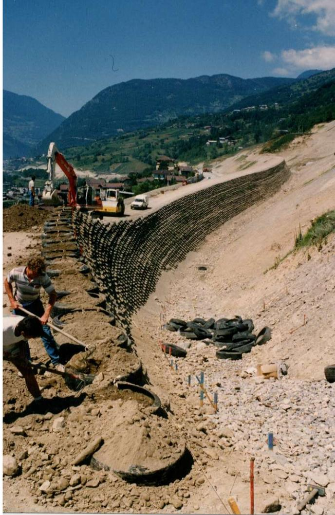
**Mur de protection contre les chutes de blocs, parement en Pneusol, renforcement en géotextiles (Pneutex)**
