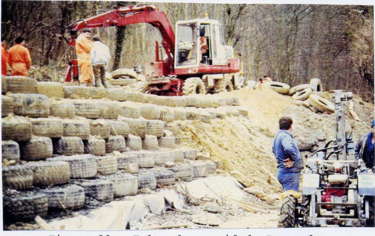
Figure 99 : Talus du massif de Pneusol
